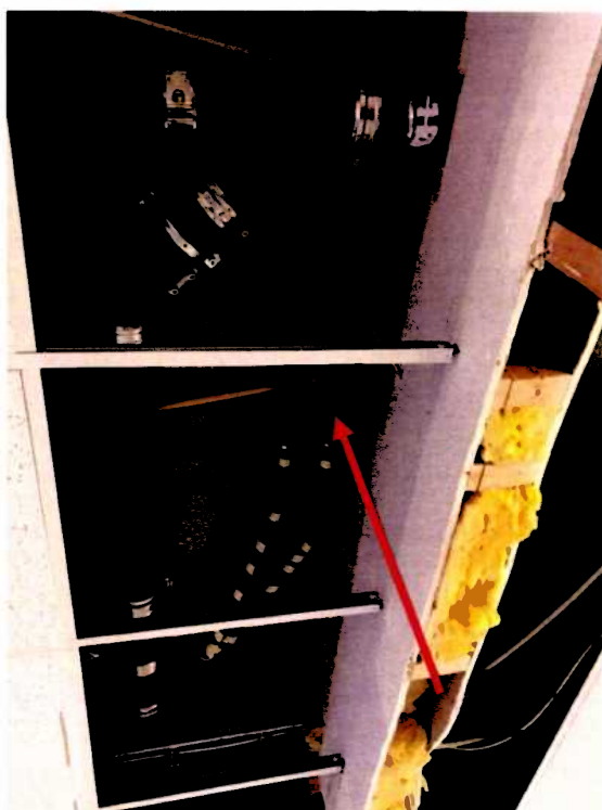
Figur 1: Cellegummiisolasjon over himlingsplater.
