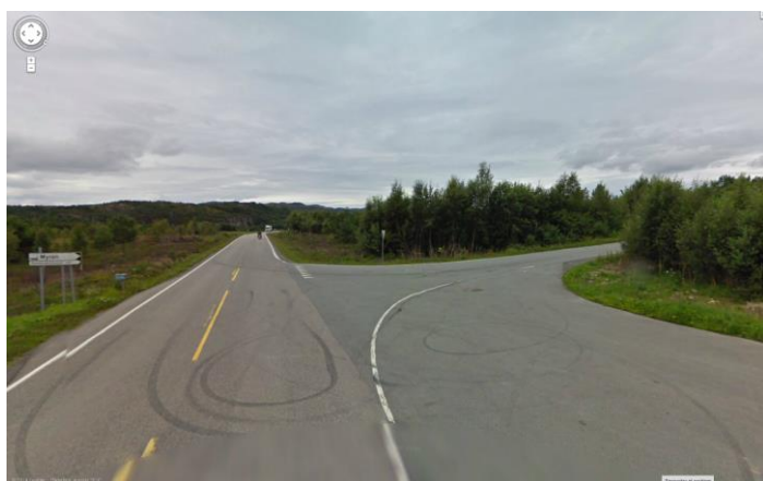
Figur 12 Eksisterende adkomst til Myran industriområde fra fv 710 fra øst
