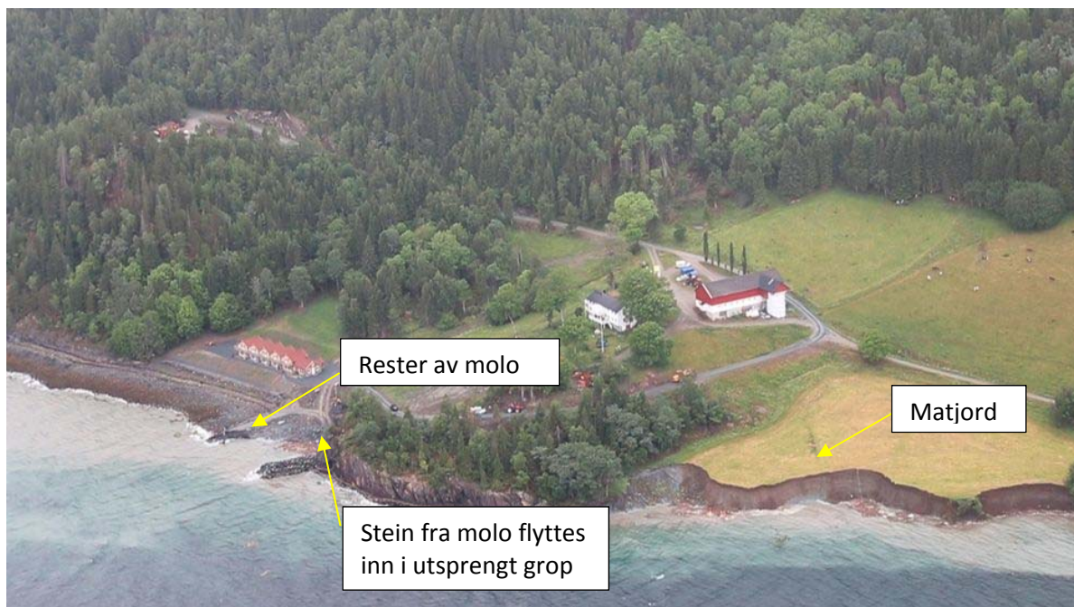
Figur 1. Flyfoto med angivelse av områder med planlagt masseflytting
