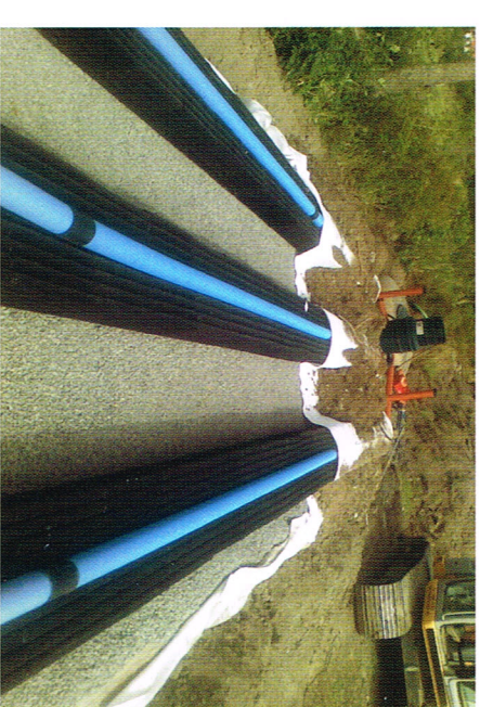
Medfølgende fiberduk 12 x 4 m legges ut over BioModulene og sprederet for å forhindre at grøften og BioModulene blir forurenset. Fiberduken legges over og på siden av BioModulene.
