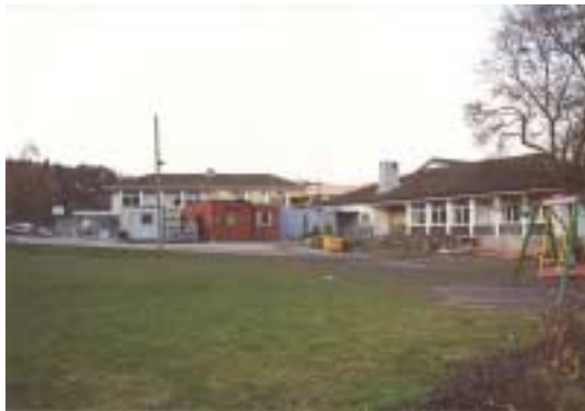
Figur 14 Bildet viser selve skoleplassen, et lunt oppholdsareal mot sørvest. Skolen er her under utbygging.
