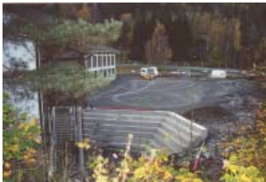
Figur 15 Skolen har mange bruksmuligheter. Bildet viser fotballbanen, som ligger helt nord på skoleområdet, og amfiet ned mot musikkrommet. Bak skimtes den trafikkerte Nesoddeveien (RV 156).
