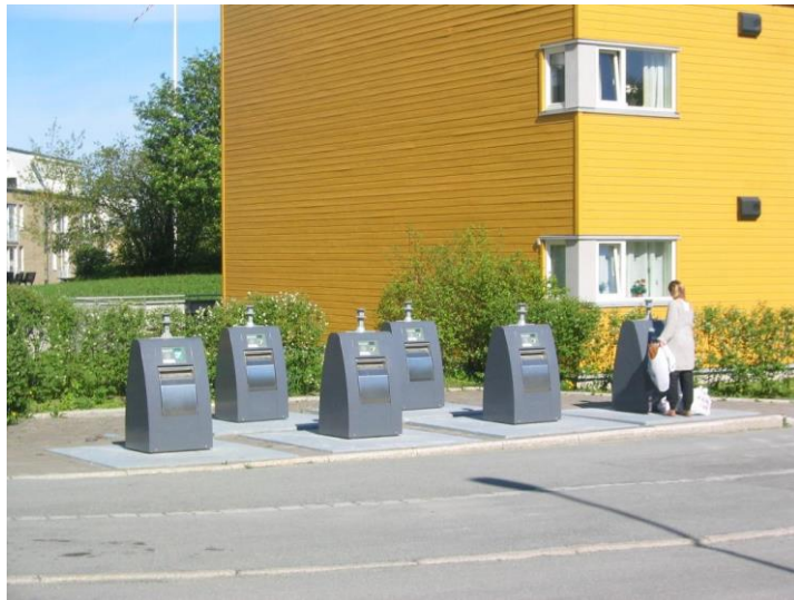
Nedgravde containere for kildesortert husholdningsavfall i byomformingsområde i Trondheim. Avfallet lagres under bakken – i container rett under nedkast. Containerne har adgangskontroll (nøkkelbrikke). (Foto: Rambøll)
