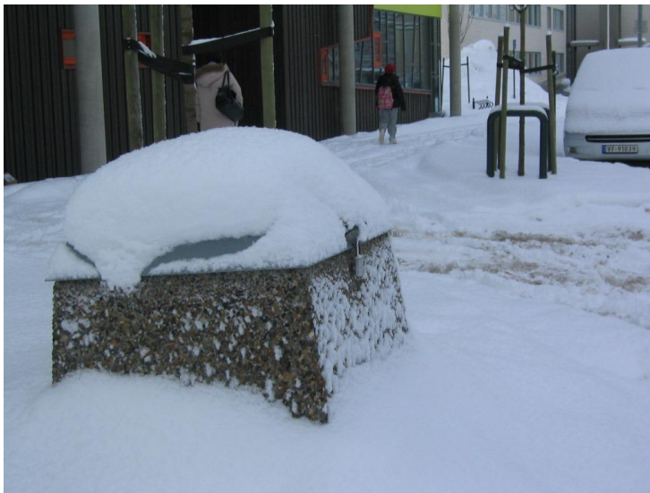
Dokkingpunkt for mobilt avfallssug. Ved tømning åpnes lokket, og slange fra sugebil kobles på slange som kommer opp i dokkingpunktet. Deretter suges avfallet om bord i bilens lastekammer. (Foto: Rambøll)
