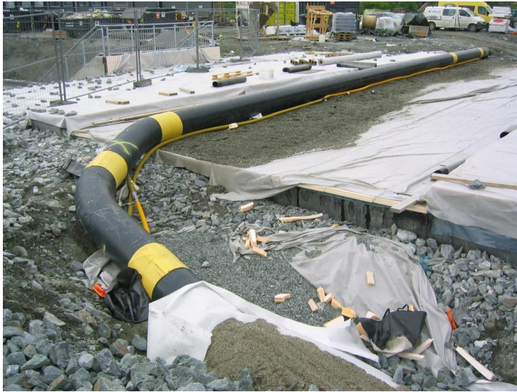
Fra nedkast går avfallet i rør under bakken til et dokkingpunkt (mobilt avfallssug) eller en avfallssentral (stasjonært avfallssug). Bildet viser legging av rør for stasjonært avfallssug på Grilstad i Trondheim (Foto: Rambøll)
