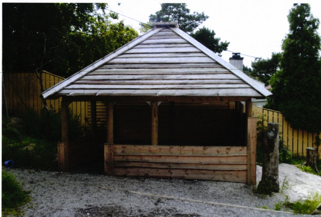
Materialvalg: Villmarkspanel eller trykkimpregnert tre. Hjørnestolper er laget av behandlet rundstokk.
