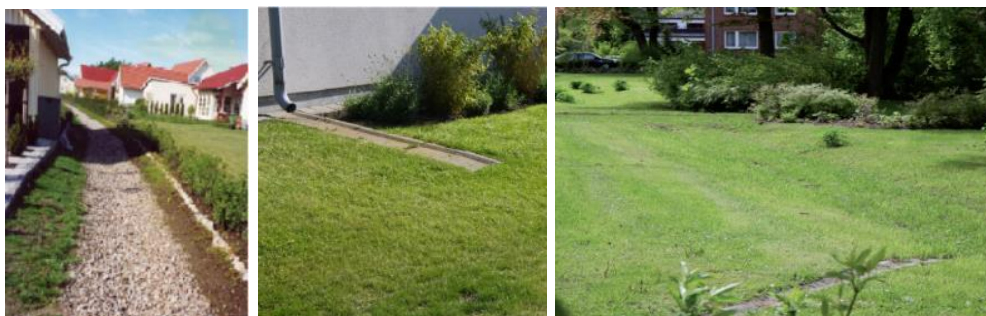
Figur 7. a) Infiltrasjonsgrøft (foto: VA-miljøblad nr92), b) Takutløp (foto: VA-miljøblad nr106, Holm, E 2013.) c) Nedsenket nedslivningsareal (foto: VA blad nr 106, 2013).
